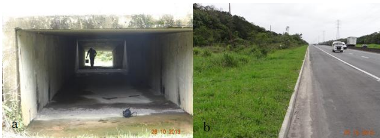
Figura 3. (a) Túnel seco construído em 2006 para servir como passagem de fauna sob a estrada e (b) ausência de tela de proteção ao longo de 3,5 km dos remanescentes de restinga e presença de mureta central na SP-55.
