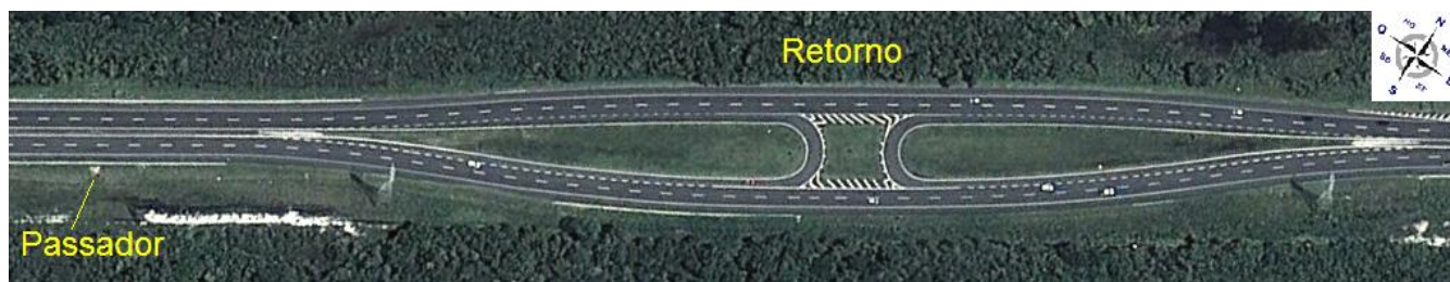
Figura 2. O lado sudeste da passagem inferior de fauna possui 20 metros de supressão de vegetação até a abertura da estrutura e o retorno de 400 metros de extensão ao lado da passagem de fauna, tem pistas próximas a borda da vegetação de restinga, gramado no meio e sem a mureta central.
